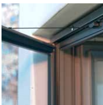
Zavírač dveří, s nastavitelnou rychlostí zavírání
